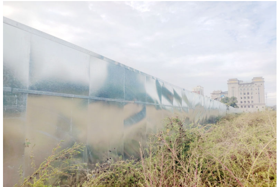
项目北侧围挡
