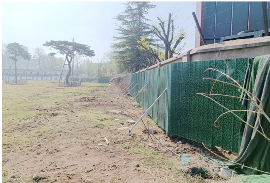
项目西侧围挡
